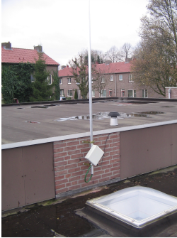
Montage aan muur
